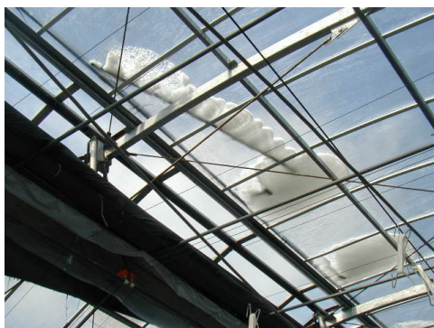
写真2 泡断熱層形成の様子
