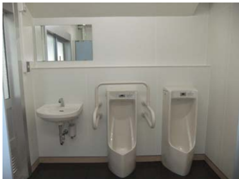
特別教室棟トイレ
