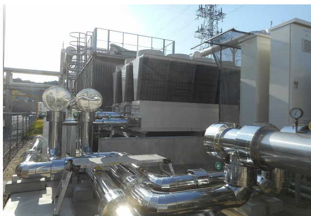
医学部附属病院 空調熱源設備増設 岡豊キャンパス
