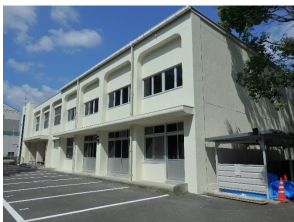
教育学部附属幼稚園管理棟外壁改修 (小津キャンパス)
