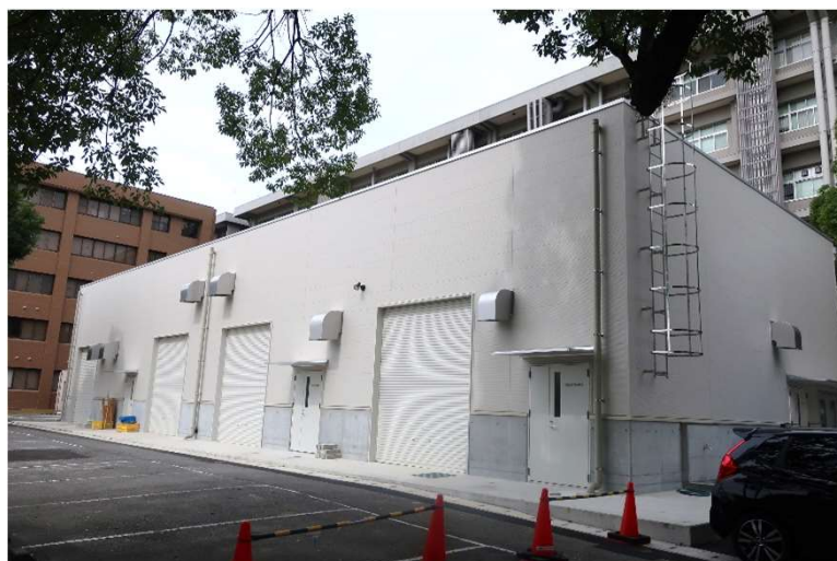
(防災工学実験棟)
