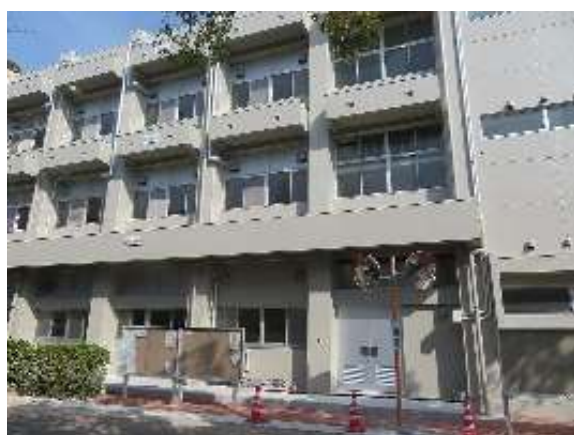
共通教育棟改修(朝倉キャンパス)
