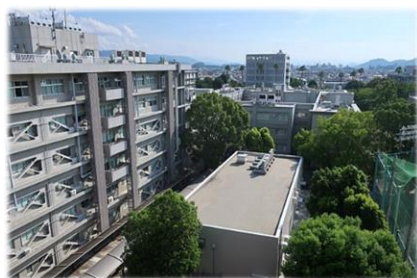
情報科学棟から望む 理工学部1号館、2号館、 防災工学実験棟
