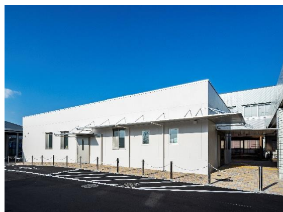
附属病院外来マルチスペース新築工事
