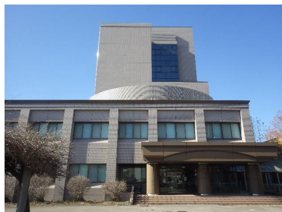
医学部看護学科棟外壁改修工事
