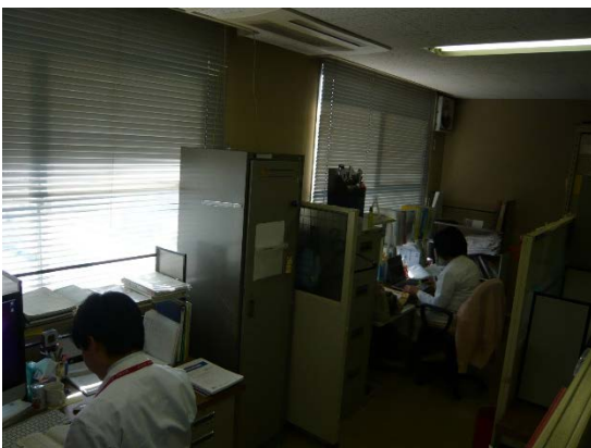
老朽化状況（照度不足）
