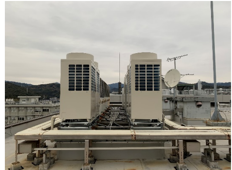
改修後：高効率型空調設備に更新
